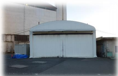
テント倉庫（リサイクル肥料保管場所）
