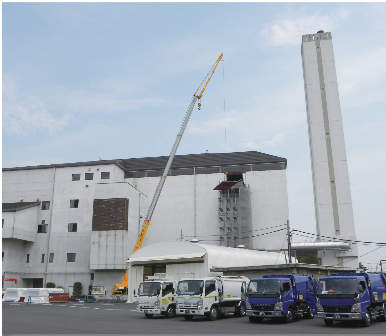
平成 25 年～平成 29 年に実施した延命化工事の様子
