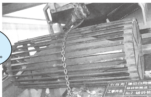
粗大ごみ処理施設の破砕物搬送コンベア補修工事の様子
