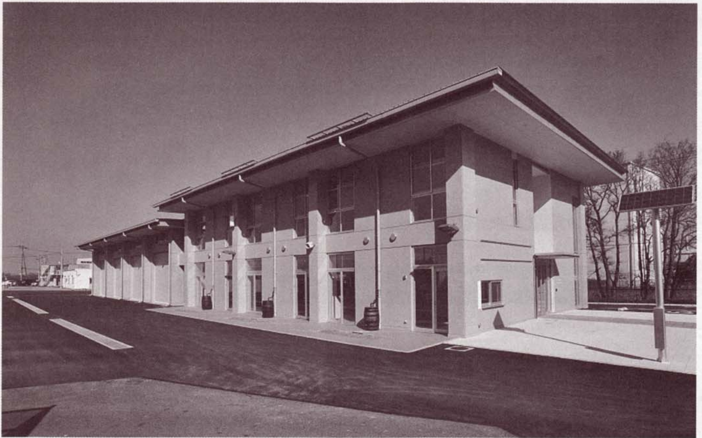
蓮田白岡衛生組合 リサイクルプラザ(愛称：エコプラザ)の全景
